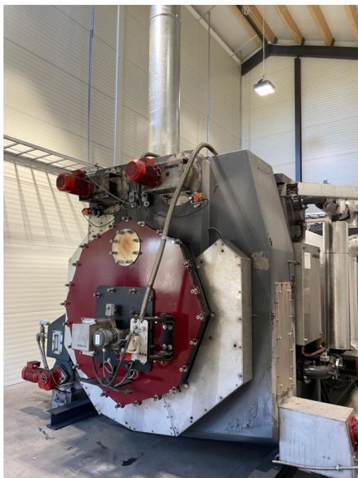
Figur 14: Biomacon pyrolyseovnen til OBIO og pakkerommet der biokull pakkes i storekker (Foto: Torunn Hønsi)
